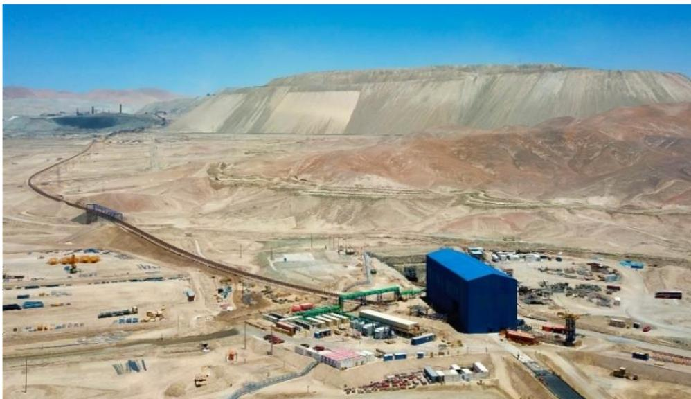
**Bild 1:** Übergabestelle vom untertägigen Tunnelförderer zum Überlandförderer
