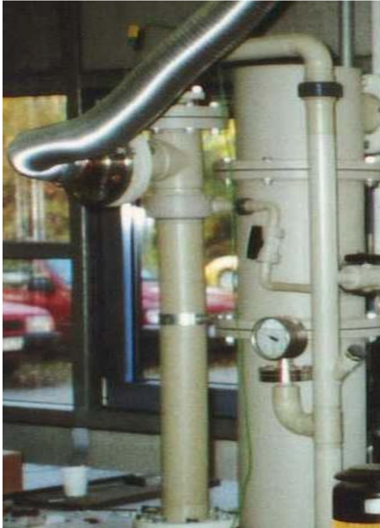
Abb. 12: Ansicht des Gaswäschers
