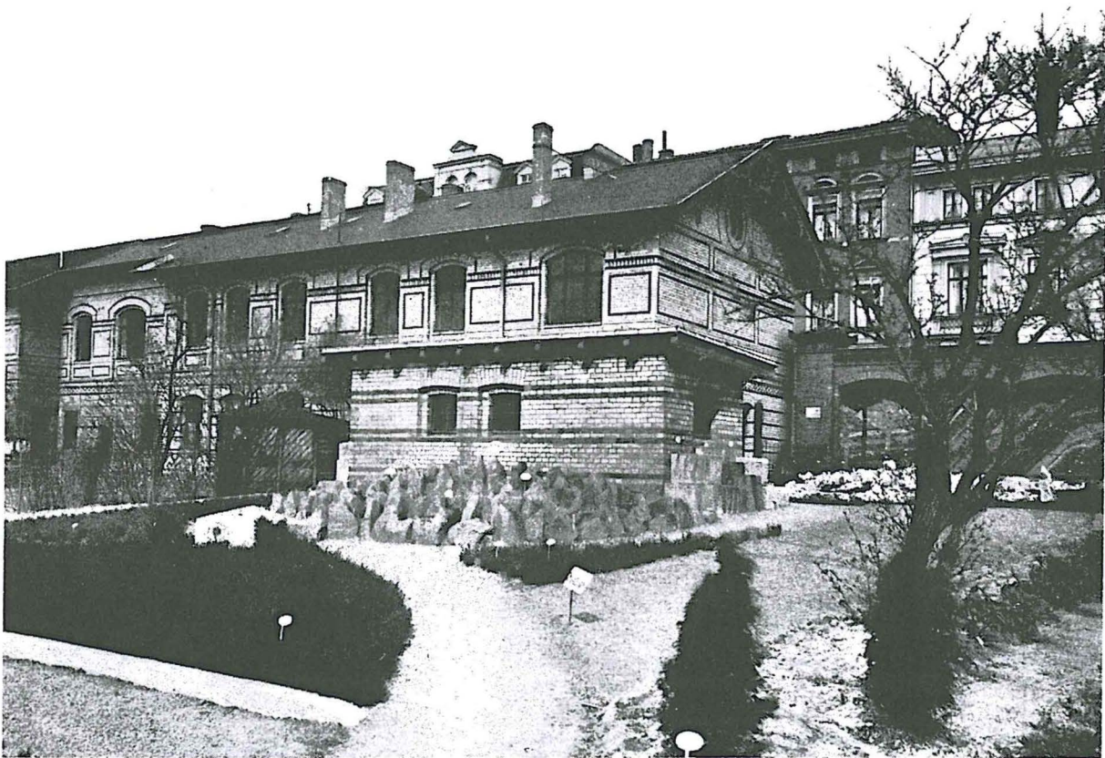
Abb. 9: Heide- und Steppenvegetation mit Silikatgesteinsblöcken vor der Fischbrutanstalt im Vordergrund. Nach rechts schließen im Hintergrund das Gipsbeet und die stratigraphisch jüngeren Teile des gemauerten Geologischen Profils an die größeren Gebäude der ehem. Molkerei und Maschinenabteilung der Landwirtschaftlichen Institutseinrichtungen an. Foto: KÜHN-Archiv 1914, Tafel XIV.
