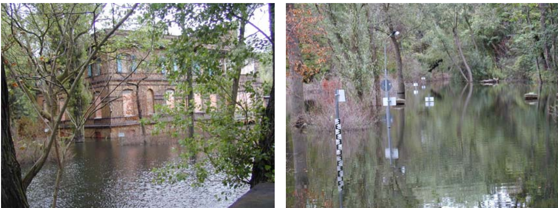
Abb. 2 a und b: a, Bauermeister-Villa (links) und b, Deutsche Grube Bitterfeld (rechts) im Juli 2004, nach Beendigung der Wasserhaltung. Das Haus wurde im August 2004 abgerissen (GRIMMER & LEMPP 2005).
