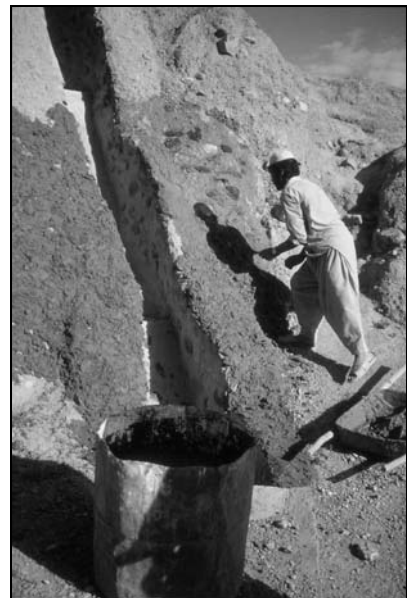
Renovation der Entwässerung©
