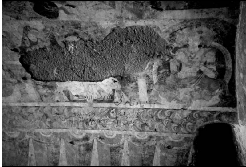
Eindringendes Wasser beschädigte die Wandmalereien beim Grossen Buddha©
