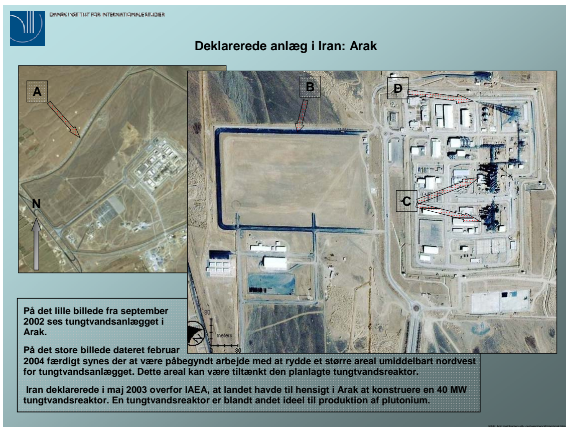
Figur 13. Processen med konstruktionen af tungtvandsanlægget i Arak
