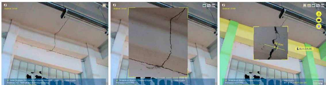
Bild 2-25: Baubestandsaufnahme mit Augmented Reality Unterstützung [GRE01]
