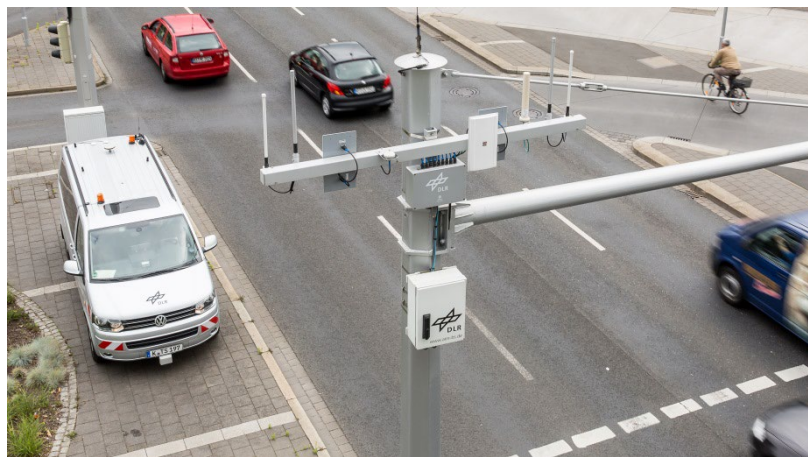
Abbildung 4: Mastaufbau an der AIM-Referenzstrecke
