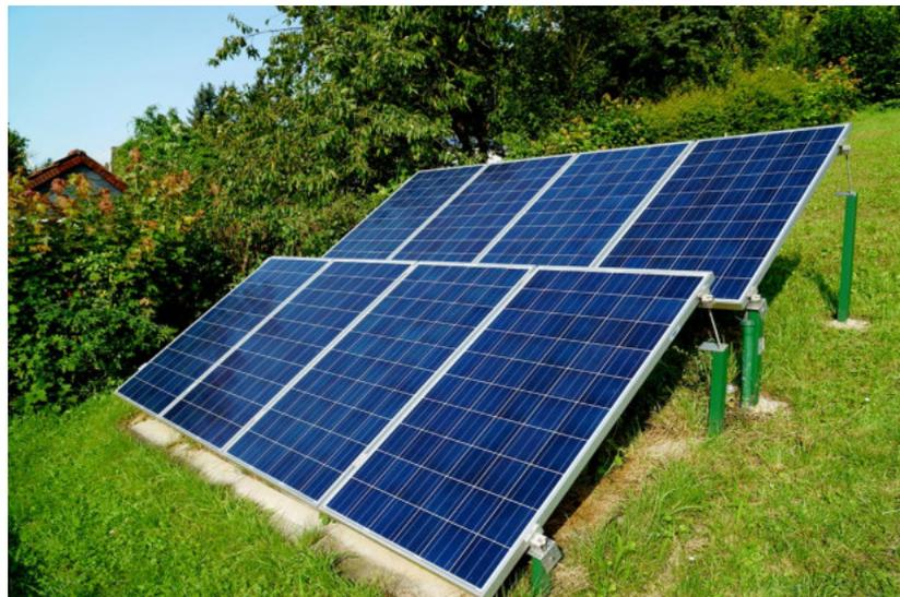
Abbildung 3.2: Freilandmontage einer Photovoltaikanlage Quelle:<https://www.mini-solaranlagen.com/garten/>
