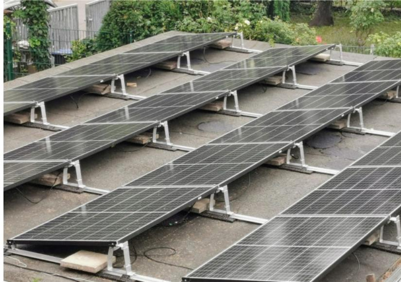
Abbildung 3.4: Montage einer Photovoltaikanlage auf einem Flachdach Quelle: <https://blog.photovoltaik-power.com/2020/07/installation-der-selbst-geplanten.html>
