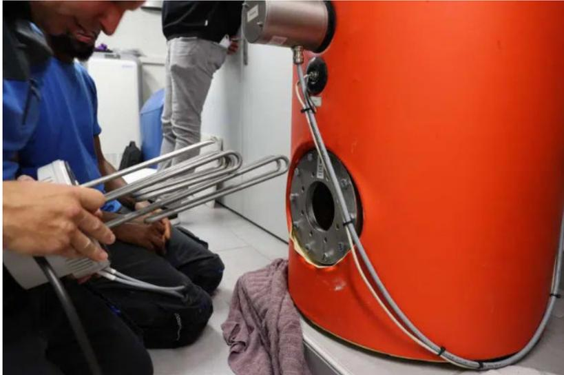
Abbildung 4.1: Heizpatrone in einem Pufferspeicher Quelle: <https://www.enbw.com/blog/energiewende/solarenergie/heizen-mit-photovoltaik-und-heizstab-so-funktioniert/>
