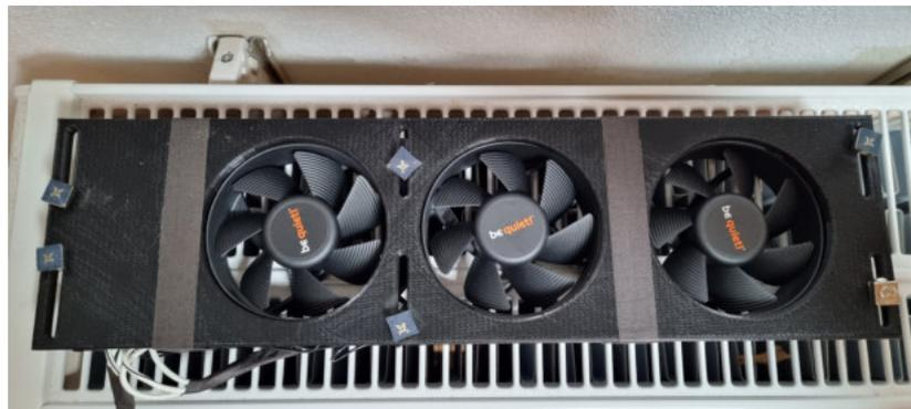
Abbildung 7.3: Heizungsbooster Draufsicht
