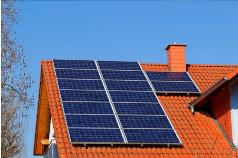
Abbildung 3.5: Aufdachmontage einer Photovoltaikanlage auf einem Schrägdach
