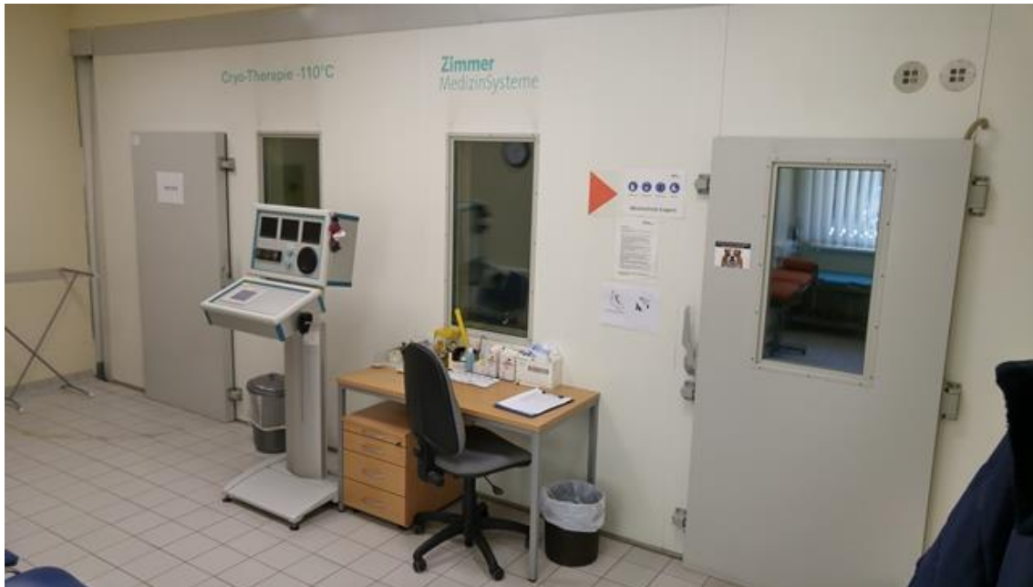
Abbildung 1: Kältekammer der HELIOS-Fachklinik Vogelsang-Gommern GmbH, rechts -10°C, Mitte -60°C und links -110°C mit Notausgangstür.
