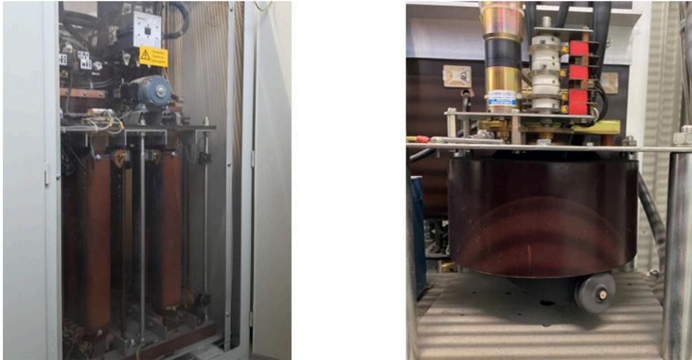
**Abbildung 6:** Verstellbare Transformatoren einer stationären EVA
