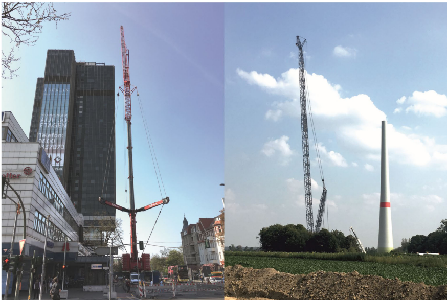
Abbildung 2: Einsatz eines Mobilkranes mit Auslegerlänge von 150 m zur Installation eines Turmkranes aufs Bürohochhaus (120 m) am Steglitzer Kreisel in Berlin (links) und Aufbau einer Windkraftanlage Salzgitter (rechts)
