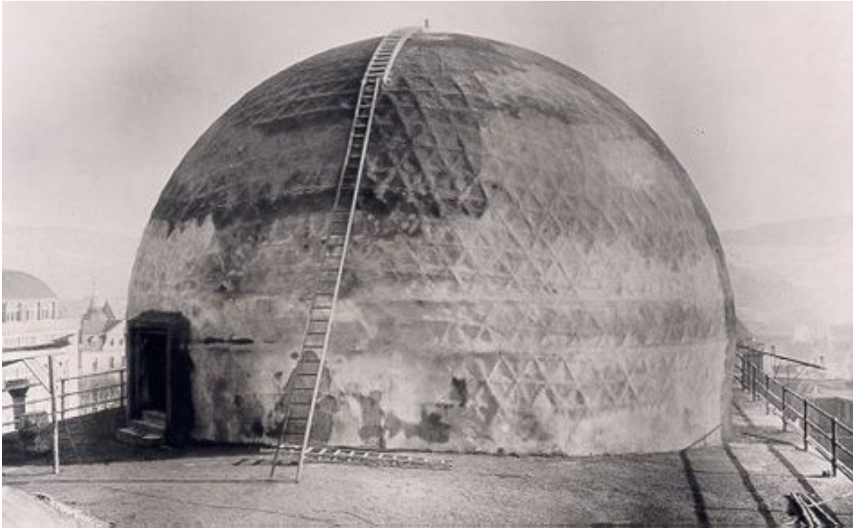
Abb. 3.4-1 Konstruktion des ersten Projektionsplanetariums auf dem Dach des ZEISS-Werks in Jena © ZEISS 1922.
