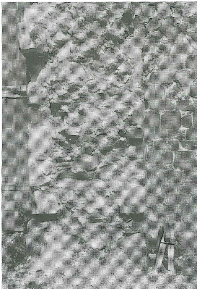
Abb. 2: Gotisches Schalenmauerwerk, Johanneskirche Ellrich. (Foto: HEISE)
