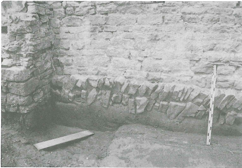
Abb. 1: Romanisches und gotisches Gründungsmauerwerk, Kirche Schwerzau. (Foto: HEISE)
