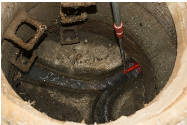
Abbildung 5: Probenahme mit Probenahmehilfsmittel 1. Der Probenahmebehälter wurde in den jeweiligen Abwasserstrom gehalten, um eine Probe zu gewinnen.
