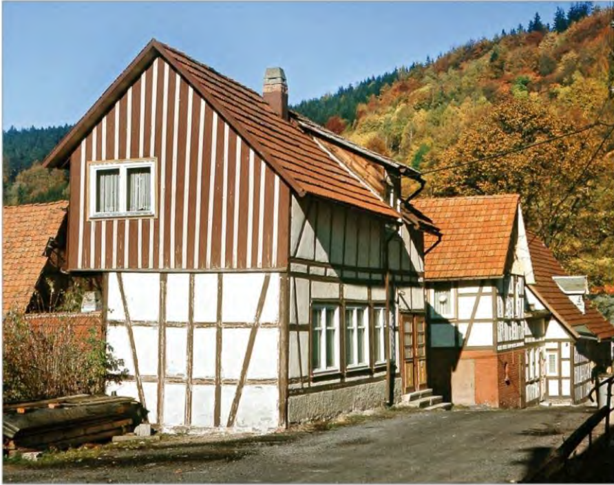
Die Obere Mühle im Jahr 1990, vor dem Abriss des unteren Gebäudekomplexes
