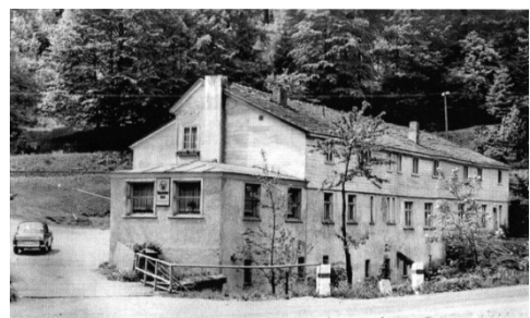
Abbildung 73 Thomasmühle mit Gaststätte in den 1960-er Jahren. (Schneider 2022)
