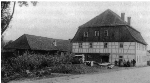
Abbildung 57 Hinternah. Mühlengebäude um 1895. (SB 2022, S. 15)
