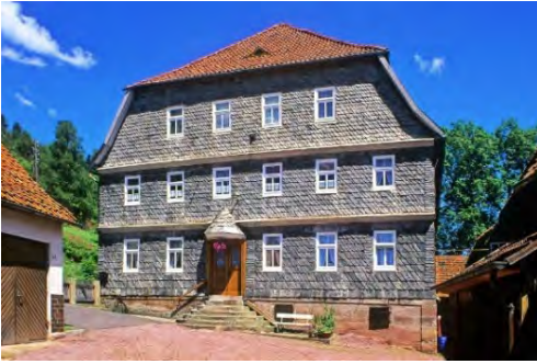
Abbildung 59 Hinternah. Wohnhaus. (Heß 2024a)
