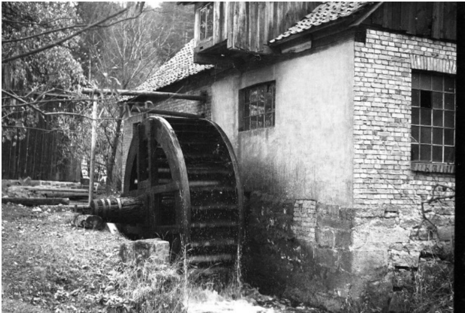
Abbildung 8 Forkelsmühle. Wiedersbach. (Grüber 2024)
