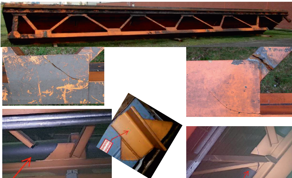
Bild 7: Gerissene Knotenbleche an einem Horizontalträger; links unten: herausgefallenes Stück [1]
