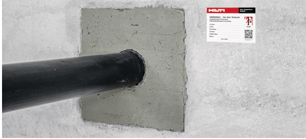
(a) Mörtelschotts
