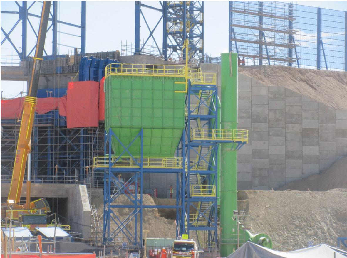
**Bild 10:** Montage der Filteranlage
