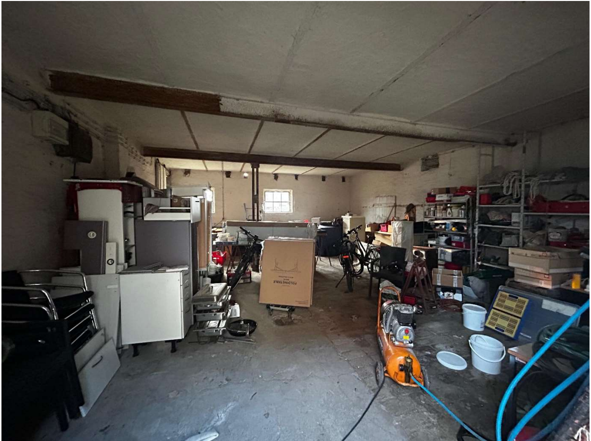
Abbildung 7.1: Deckenkonstruktion mit Stahlträgern
