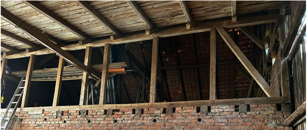
Abbildung 7.4: offengehaltene Außenwand und Lufteinlässe
