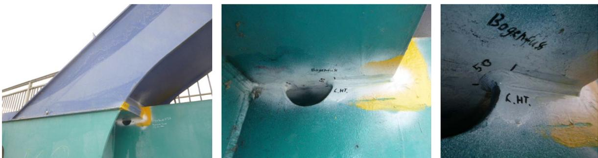
*Abb. 6: Rissausgangspunkt am Freischnitt einer neuen Brücke.*
