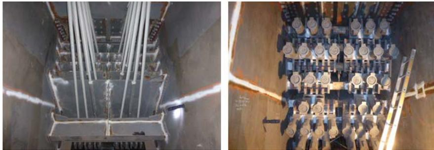
*Abb. 4: Seilkammer mit Schubeinleitungsebenen*
