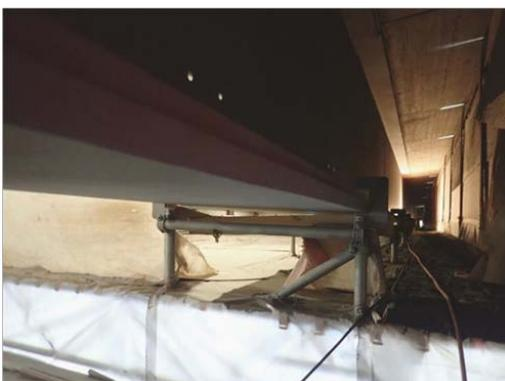
*Abb. 7: Brücke mit Einhausung. Ansicht von innen mit Strahlschutt.*
