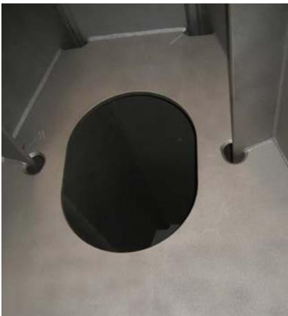
*Abb. 5: Ovale Öffnung (Mannloch) am Brückenbauteil.*
