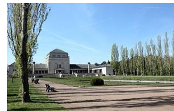
Abb. 2 Blick auf das Zentralgebäude des Gertraudenfriedhofs, Halle/S.
