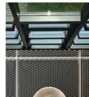
Fenster Holz- und Stahlrahmen
