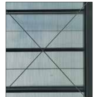
Dach Foyer Stahl-Glaskonstruktion
