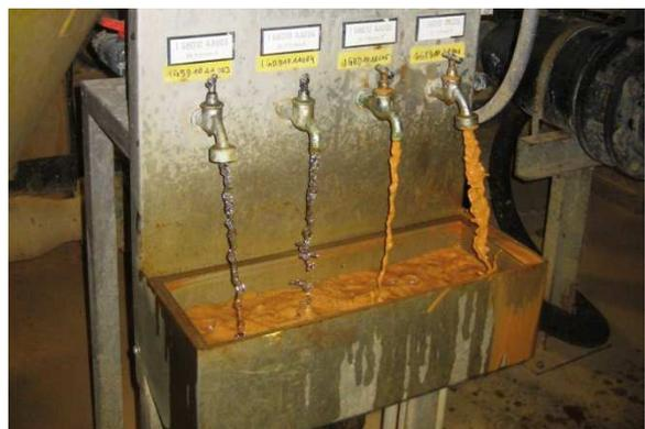
Abb. 0-25 Probenahmestation
