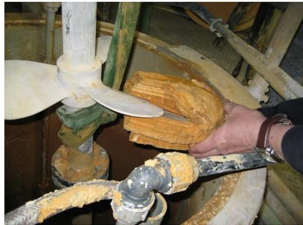
Abb. 0-12 Reinigung des Rührwerkes
