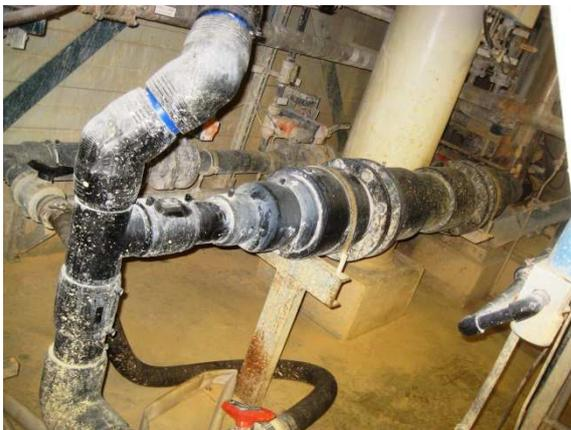
Abb. 0-24 Kontaktschlamm-Hutsieb, nachgerüstet
