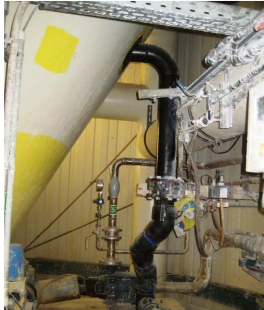
Abb. 0-17 Kontaktschlammabzug, höher gelegt
