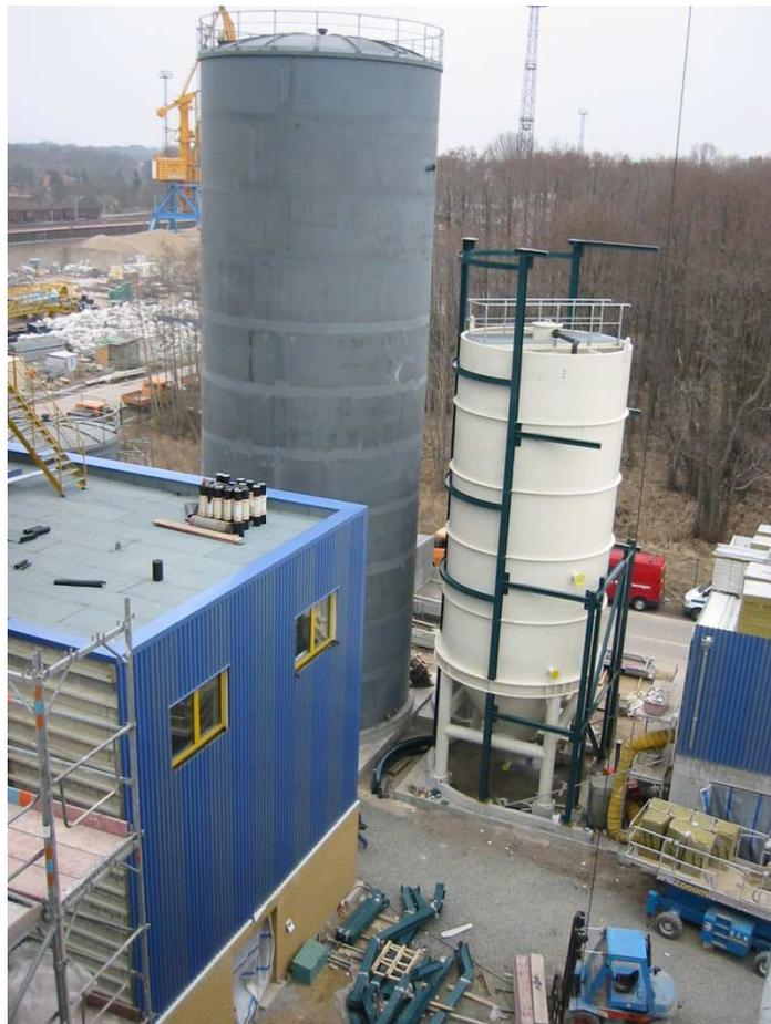
Abb. 0-4 Errichtung Reaktorgebäude im Jahr 2003 (links davon der Löschwasserbehälter)
