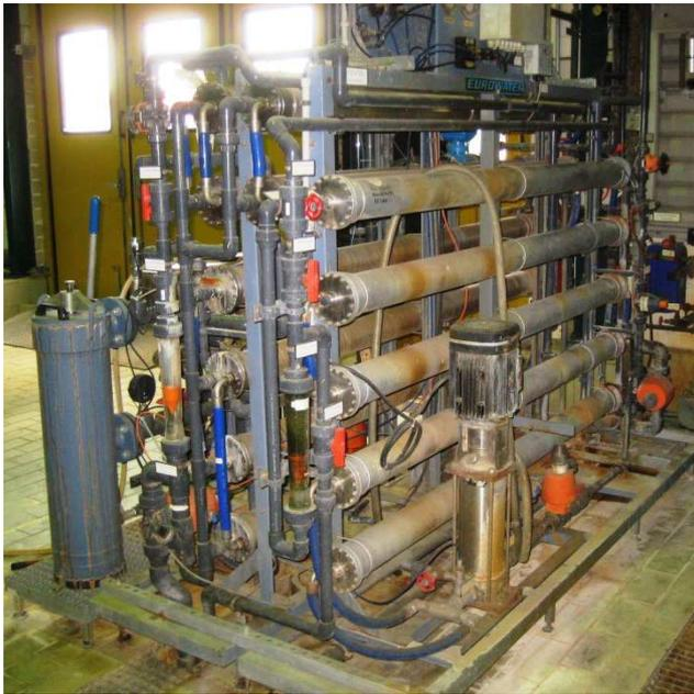
Abb. 0-6 Umkehrosmose stationär, 2-stufig
