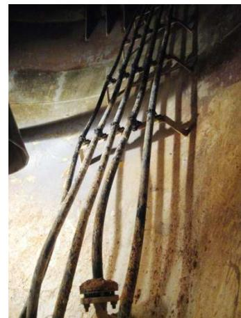
Abb. 0-14 Probenahmeleitungen im Reaktor vor der Demontage
