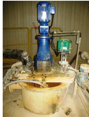
Abb. 0-10 Rührwerk und Kalkmilchregelventil, nachgerüstet
