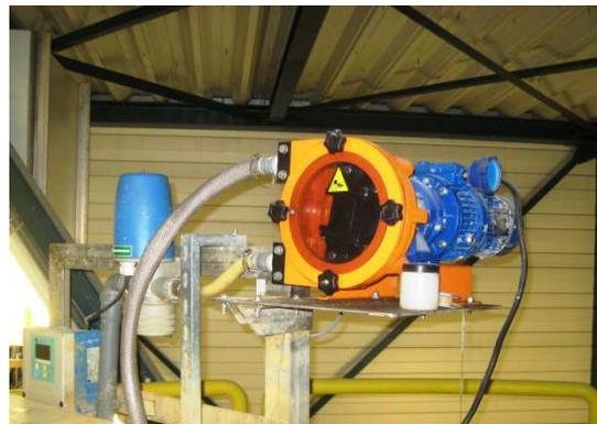
Abb. 0-19 pH-Messung und Messkreispumpe
