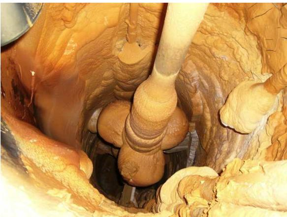
Abb. 0-11 Mischzone mit Kalkablagerungen
