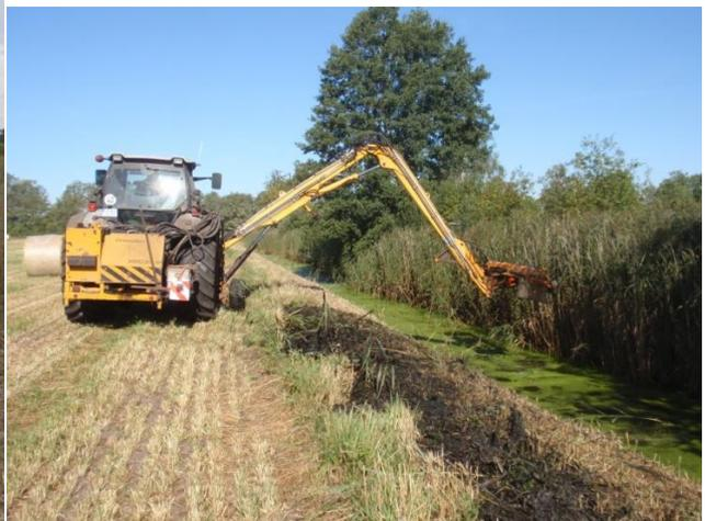
Abbildung 12: Entfernung von Ästen und Schlamm aus Köckte 27
