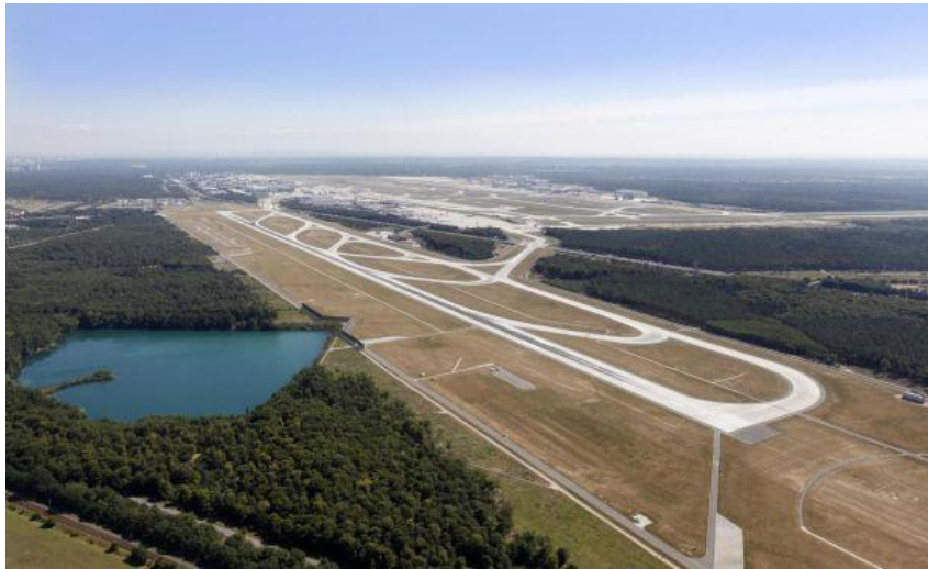
Abbildung 1: Landebahn Nordwest im FFH-Gebiet „Kelsterbacher Wald“ Quelle: FRAPORT 2013a
