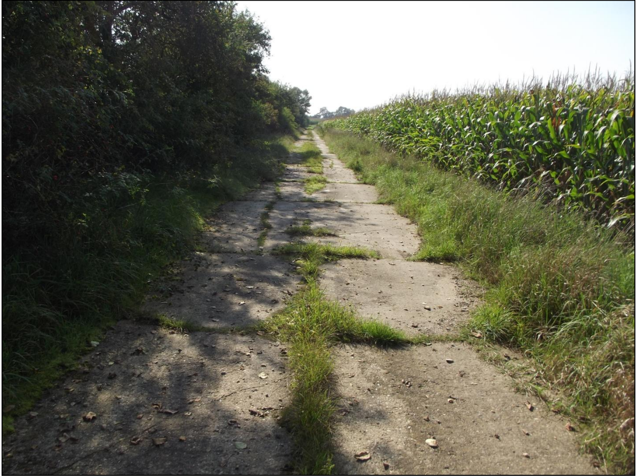
Abbildung 20: Beispiel für einen alten Betonplattenweg (Aufnahmepunkt 11) (BAUTZ 18.09.2014)
