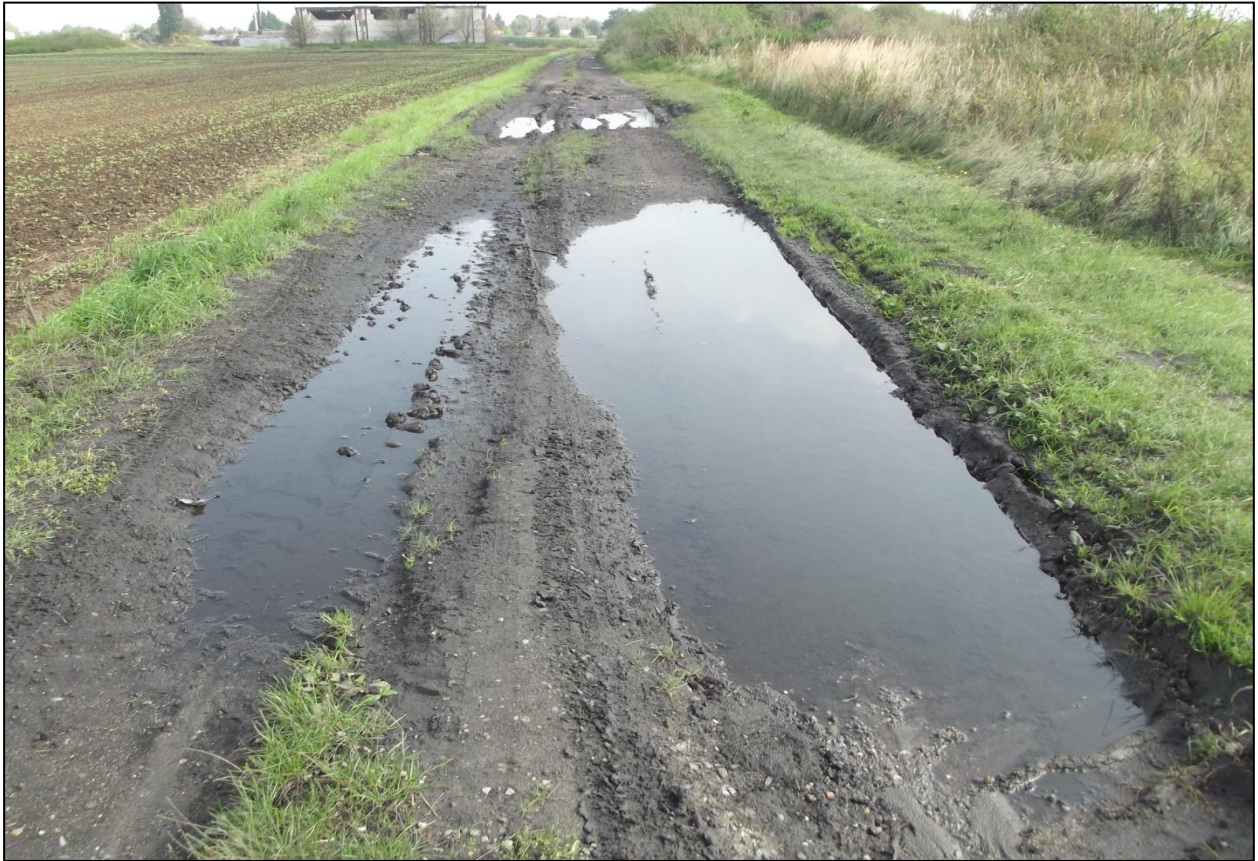
Abbildung 12: Beispiel für ein großes Schlagloch (Aufnahmepunkt 22) (BAUTZ 20.09.2016)
