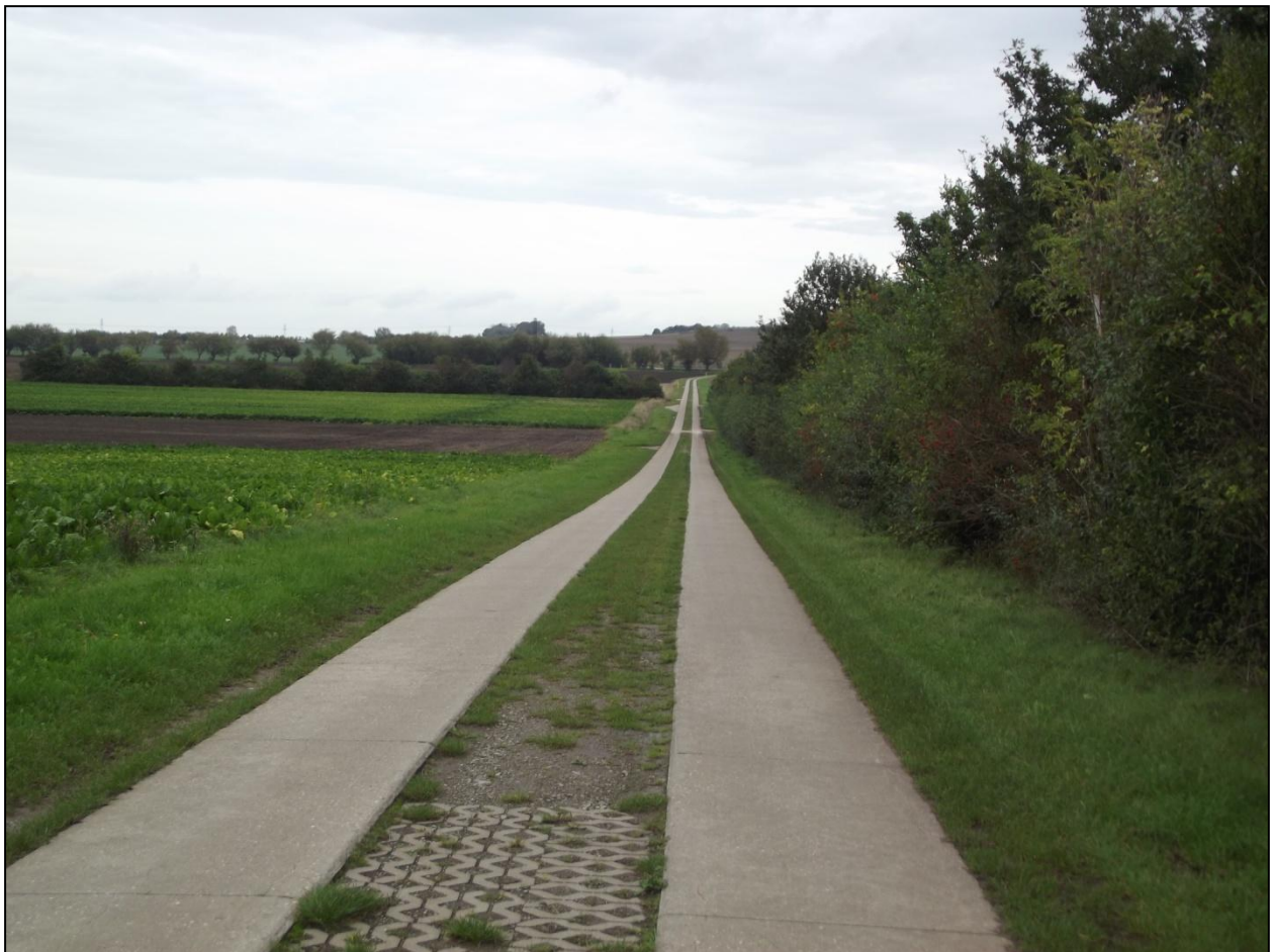
Abbildung 17: Beispiel für einen Wechsel des Mittelstreifens bei Spurbahnen (Aufnahmepunkt 49) (BAUTZ 21.09.2014)
