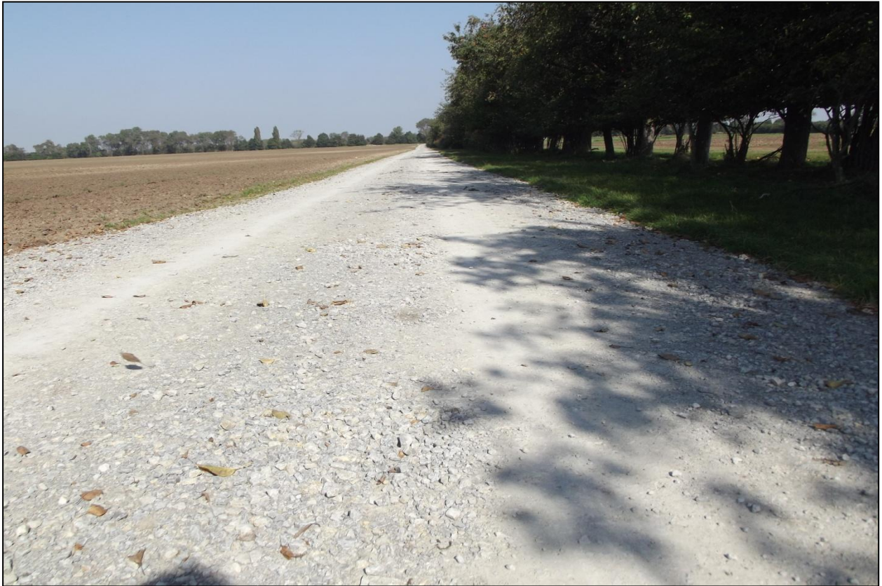
Abbildung 27: Beispiel für einen fehlenden Randstreifen (Aufnahmepunkt 12) (Bautz 18.09.2014)
