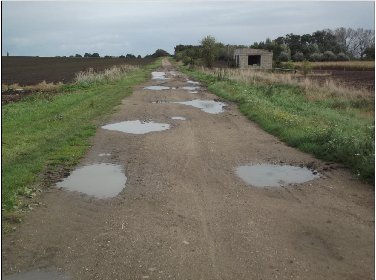
Abbildung 11: Beispiel für viele Schlaglöcher (Aufnahmepunkt 64) (BAUTZ 22.09.2016)
