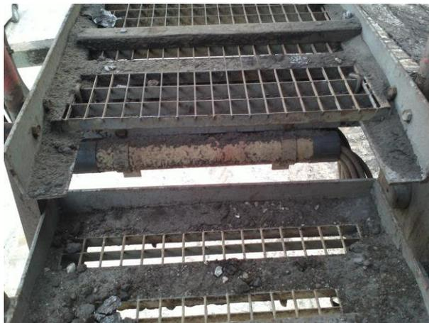
Abb. 4.32: Schwebender Übergang zwischen zwei Laufstegabschnitten
