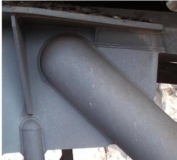
Abb. 4.13: Umlaufender Kehlnahtanschluss an Knotenblech
