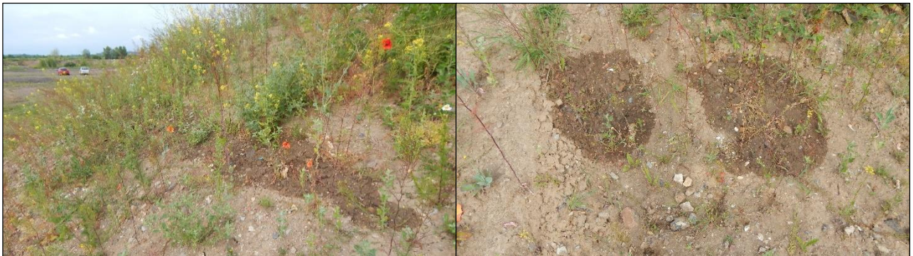
Abbildung 4-1 Austritt der Sickerlinie Deichseite HF3 und Deichecke HF3-HF4
