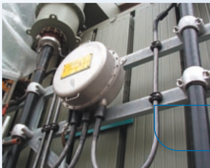
Anschlusskasten für einseitige Erdung installiert an Transformator-Endverschlüssen
