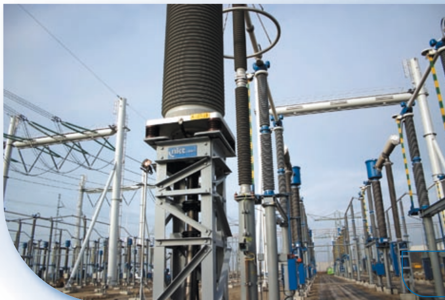
Freiluftendverschluss mit Verbundisolator Typ FEV 420-V
