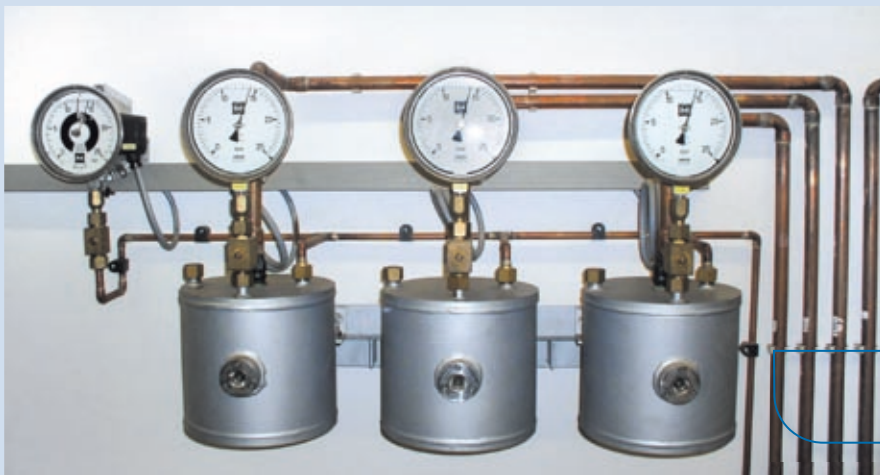
Öldrucktanks für Niederdruckölkabel
