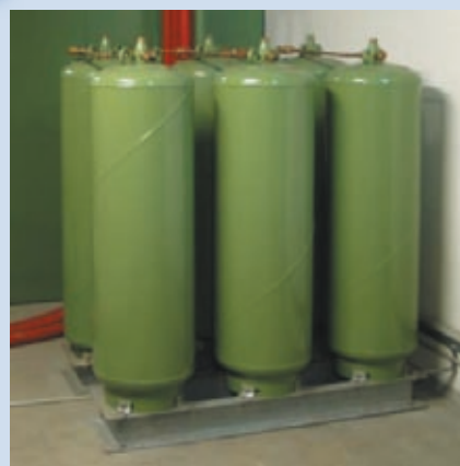
Öldrucktanks für Niederdruckölkabel
