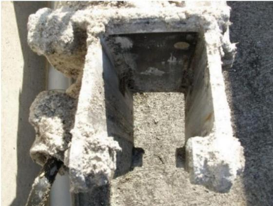
**Bild 6: Gestängeführung des Zentratspeicherrührwerks (Moser, 2014)**
