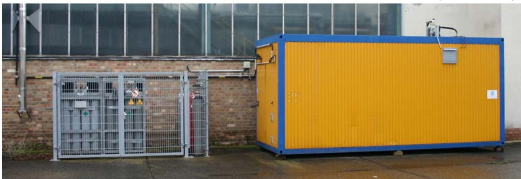
Abb. 4.2: Versuchscontainer und Gasflaschenlager nach Ausführung der Aufstellungspläne.
