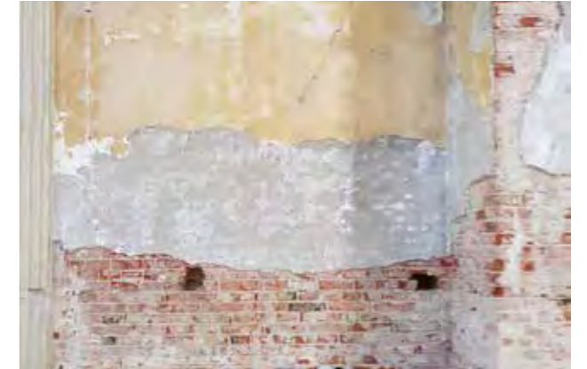
Ursprünglich waren die Innenwände mit Marmorzement verkleidet. Davon sind nur noch Teilflächen erhalten.
