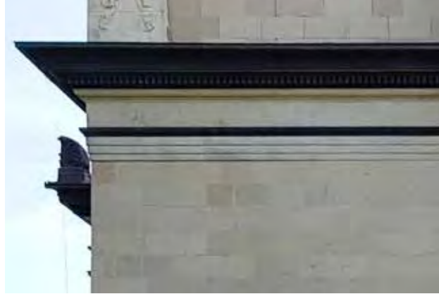
Fassadenverkleidung: heller Elbsandstein mit horizontaler Betonung durch Friese und Elemente mit schwarzem rheinischem Tuffstein.
