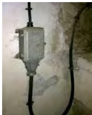
Hausanschlusskasten (Krypta) Fotos: Fabian Raddatz
