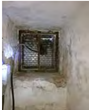
Stromzuleitung erfolgt über Kellerfenster
