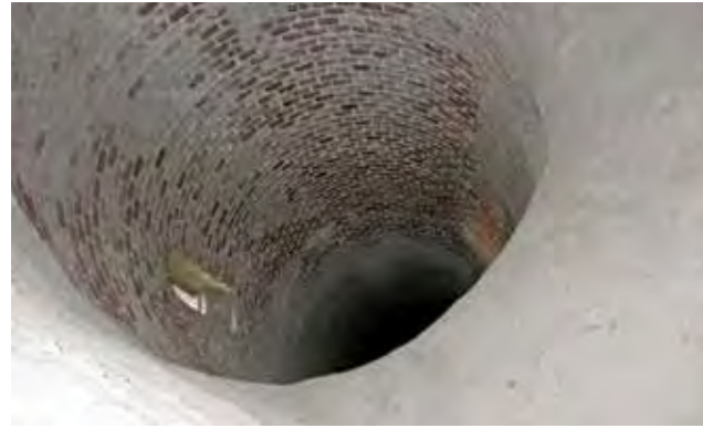
Hauptschacht (hinter Apsis)
