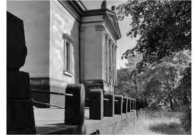
Die Brüstungspfeiler aus Basaltgestein sind baufällig, da der Sockel instabil geworden ist. Foto: Frank Boettger
