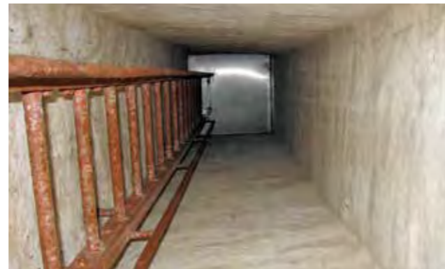
Wartungsgang (oberer Kuppelgang)
