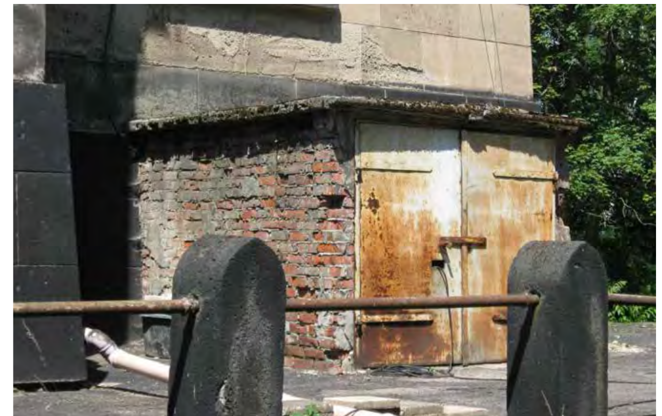
Die Hebebühne an der Südseite des Gebäudes führt in den Keller. Fotos: Fabian Raddatz
