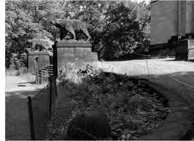
Auffahrt und Treppe zum Mausoleum sind stark sanierungsbedürftig und für Besucher gesperrt. Foto: Hochschule Anhalt
