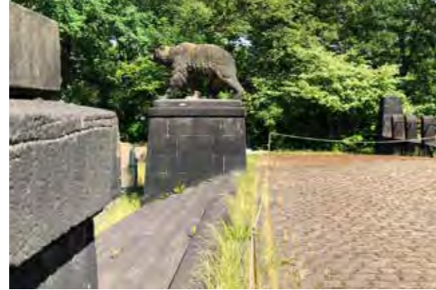
Im Außenbereich wurde für Sockel und Treppe ein vulkanischer feinkörniger Basaltstein in Dunkelgrau bis Schwarz verwendet.
