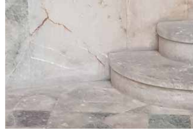
Die Treppen im Innenraum (Apsis und beide Treppen zur Krypta) sind mit hellem, fein gemasertem Marmor verkleidet.
