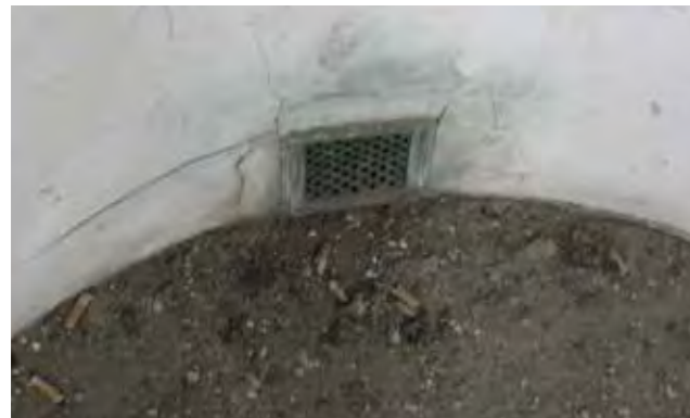
Bodenauslass (Kuppelgang) Fotos: Fabian Raddatz
