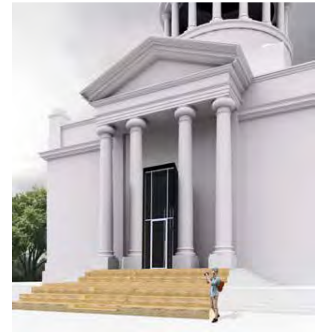
Die Treppenanlage zum neuen Entrée des Mausoleums erhält eine Überformung aus Holz. Diese dient zugleich als Tribüne mit knapp 120 Sitzplätzen.
