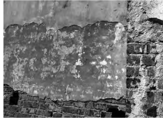
Die unterschiedlichen Putzschichten wurden bereits teilweise abgetragen. Foto: Frank Boettger
