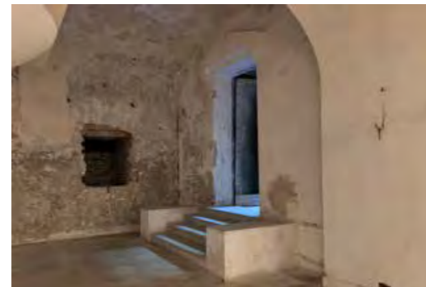
Auch in der Krypta sind starke Schädigungen des Putzes an Wänden und Gewölbe zu verzeichnen.
