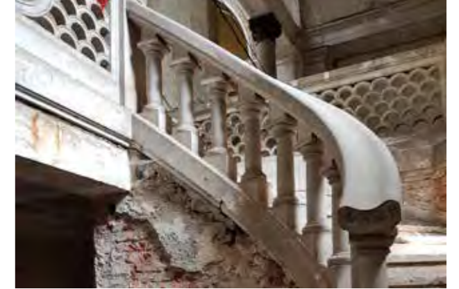
Die massiven Balustraden und Treppengeländer wurden im gleichen Marmor wie die Treppenstufen ausgeführt.
