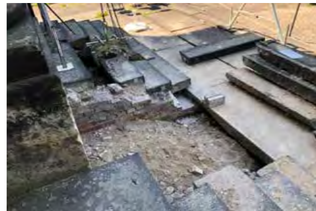
Das Gewölbe unter der Eingangstreppe ist teilweise eingestürzt und nicht tragfähig.
