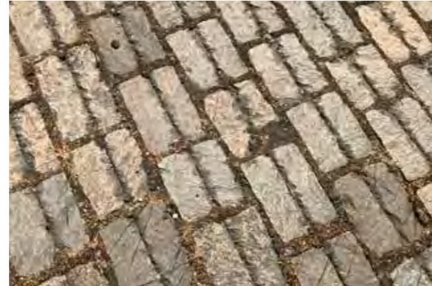
Auffahrtrampen: Das Pflaster wurde vermutlich im Zuge der Ende der Achtzigerjahre erfolgten Renovierungsarbeiten neu verlegt.
