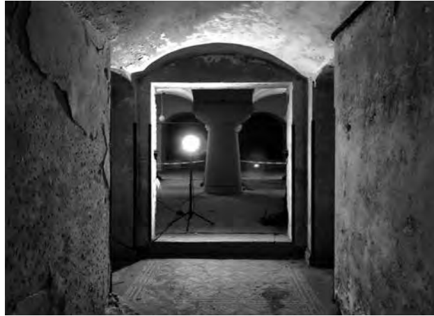
In der Krypta gibt es Licht lediglich über Baustrahler. Foto: Hochschule Anhalt
