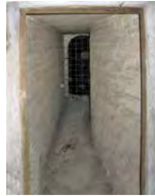
Verbindungsschacht (Aufgang Kuppel)
