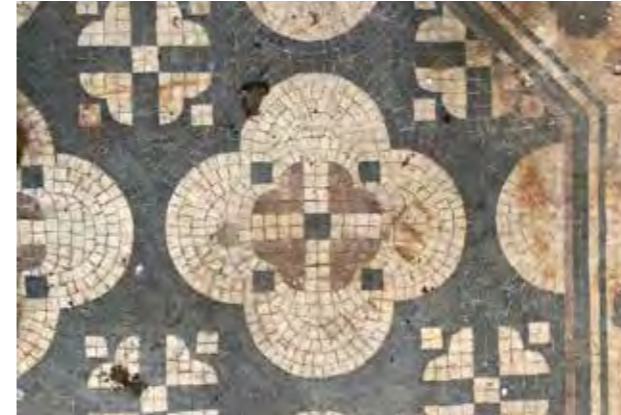
Die Bodenbeläge im Erdgeschoss sind mit aufwendigen Mosaikarbeiten versehen (Ausführung: Josef Huber).
