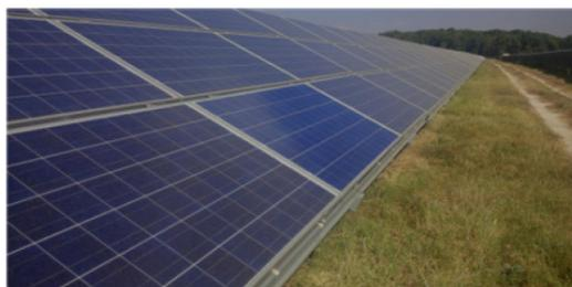
Abbildung 5.27.: Aufnahme eines Modulstrangs, welcher mit einer Staubschicht bedeckt ist. Zur Veranschaulichung wurde die Oberfläche des zweiten Moduls der unteren Modulreihe von links beginnend gereinigt.
