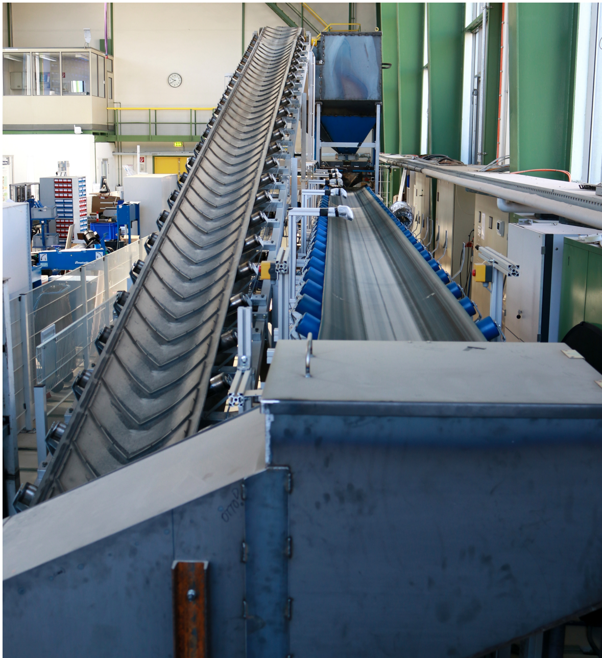
Abb. 8.1: Förderanlage mit Rückförderer in der Versuchshalle der Universität Magdeburg
