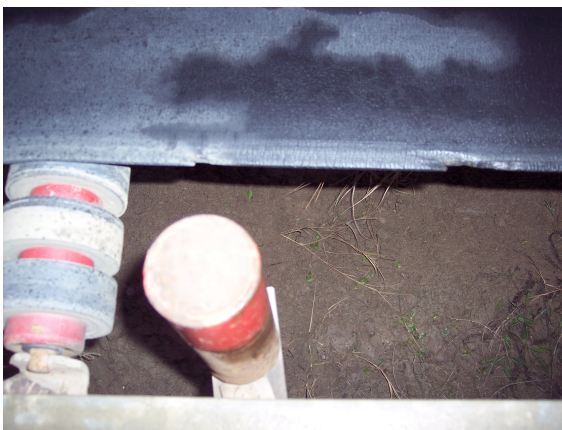
Abb. 3.31: Kantenrolle im Obertrum, die den Gurt beschädigt hat
