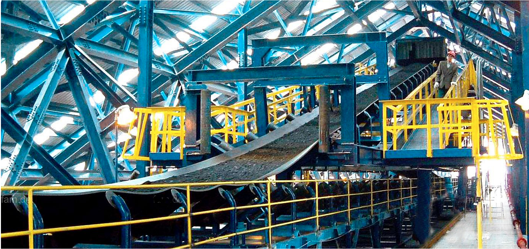
Abb. 3.41: Bandschleifenwagen mit deutlich erkennbarem Gurtschieflauf. Der Gurt läuft an die vertikalen Seitenrollen an, die diesen begrenzen sollen. Am zweiten Rahmen sind Teile der Niederhalterrollen zu erkennen, die ein komplettes Abheben des Gurtes verhindern sollen, wenn dieser unbeladen ist [40]
