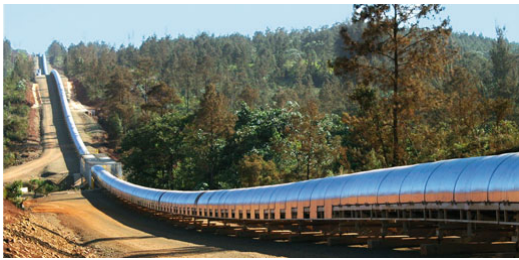
Abb. 3.26: Einhauster Fördergurt auf Cuba [14]
