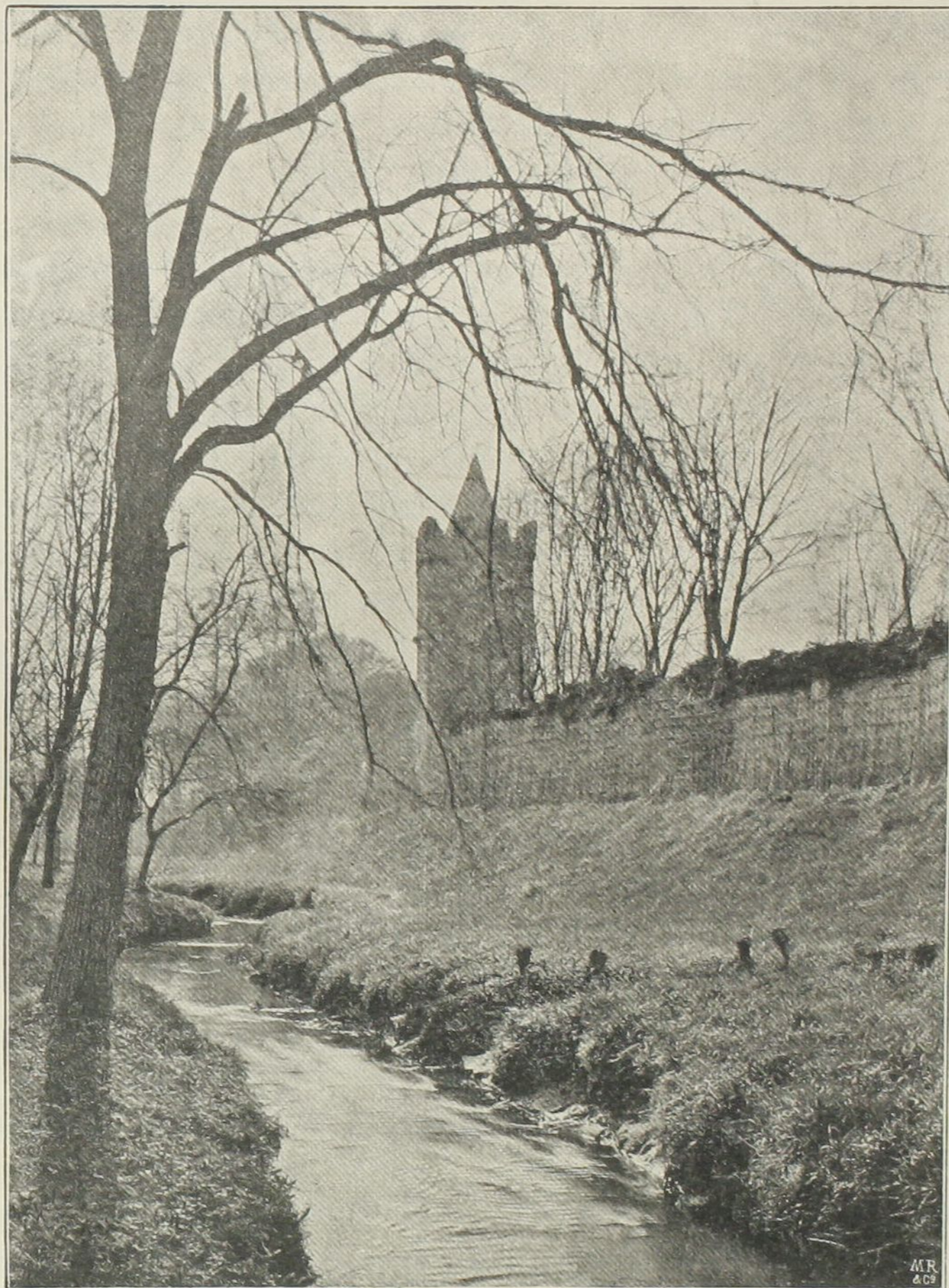
Riekinpott mit Stadtmauer.
