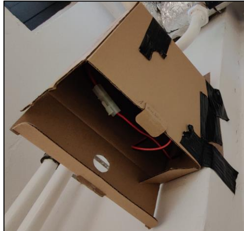
Abbildung 30: Arbeitsstation Elektroleitung geöffnet im fehlerfreien Zustand
