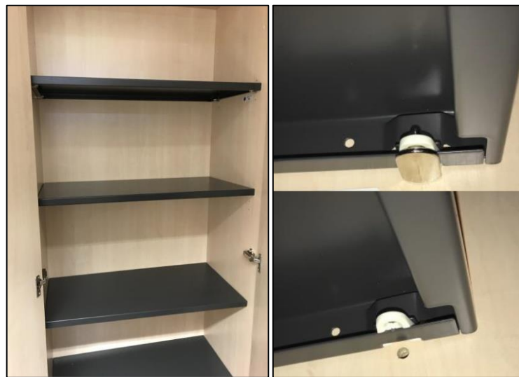
Abbildung 22: Arbeitsstation Schrankboden (links: Frontansicht, rechts oben: korrekter Zustand; rechts unten: fehlerhafter Zustand)
