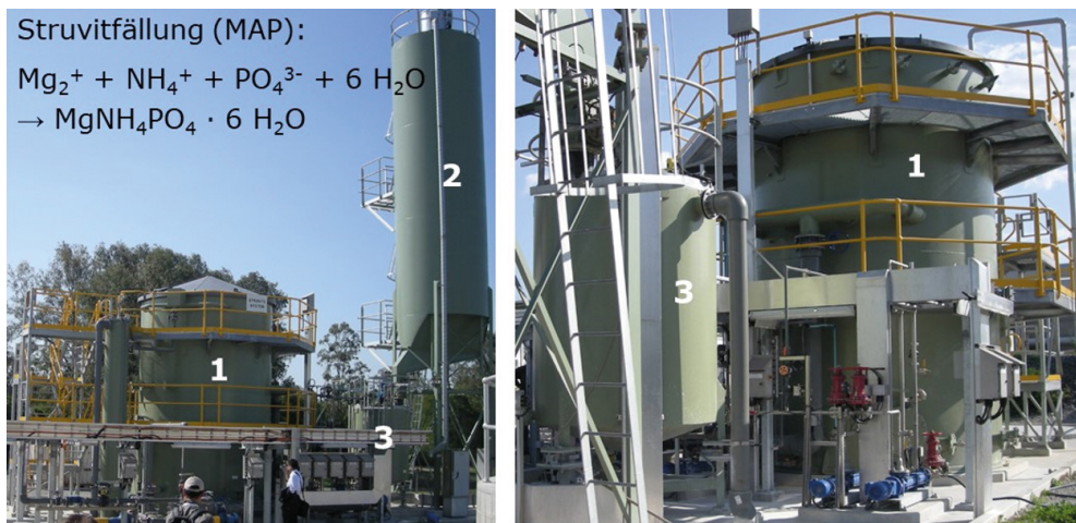
Bild 3: MAP-Reaktor (1) zur Gewinnung von MAP aus dem Schlammwasser auf der Kläranlage Brisbane (2 = MgO-Lagerbehälter, 3 = Anmischbehälter für Mg(OH) 2 -Lösung) (Bildquelle: Wiese)
