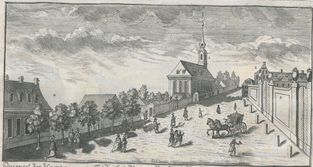
Prospect der Hauptstrasse zu Friedrichstadt gegen die Kirche, Das Vorwerk, einen Theil der Menagerie auch 2. denen zum Graefz. Brückz. Garten gehoerigen Gebäuden.
