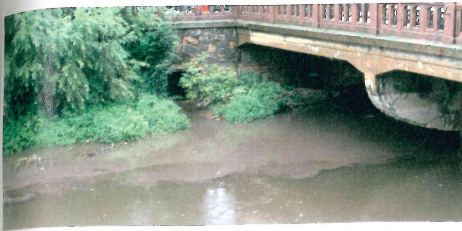
Abb. 5.1.13: Mündung des RÜ 11 (Bildmitte) und der Gerberöhre (re. Brückenbogen) während eines Mischwasserabwurfes (29.5.94)
