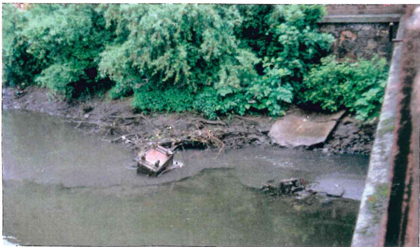
Abb. 5.1.22: Treibgut im Mündungsbereich des RÜ 11 infolge der Schlammakkumulation
