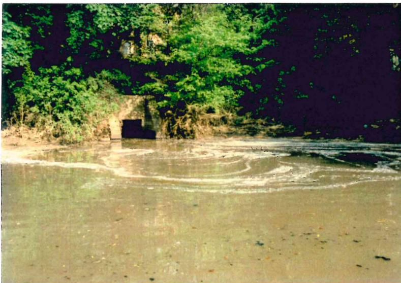
Abb. 5.1.12: Abwassereinleitung aus dem RÜ 3 (Steinmühlenerweiterung des Mühlgrabens) bei Trockenwetter (12.5.94)
