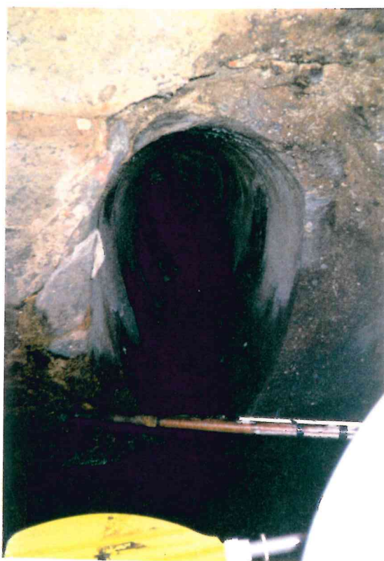
Abb. 5.1.17: Regenüberlaufmündung in der Gerberröhre (RÜ 14)
