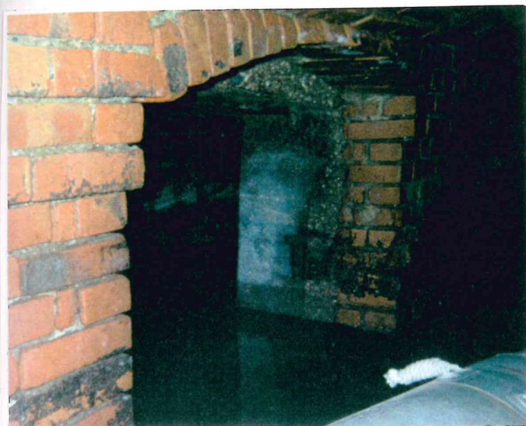
Abb. 5.1.16: Regenüberlaufmündung in der Gerberröhre (RÜ 16)
