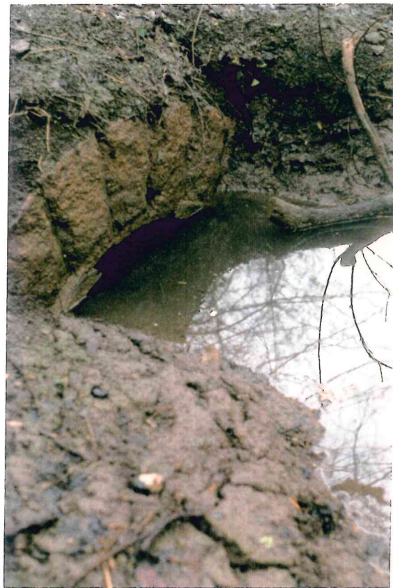
Abb. 5.1.23b: Schlammakkumulation im Mündungsbereich des RÜ 1
