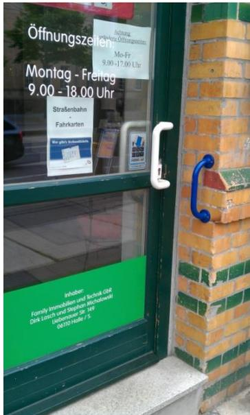
**Abbildung 25: Haltegriff am Türeingang zur Unterstützung bei der Überwindung einer hohen Stufe, eigene Aufnahme am 1.6.2011**
