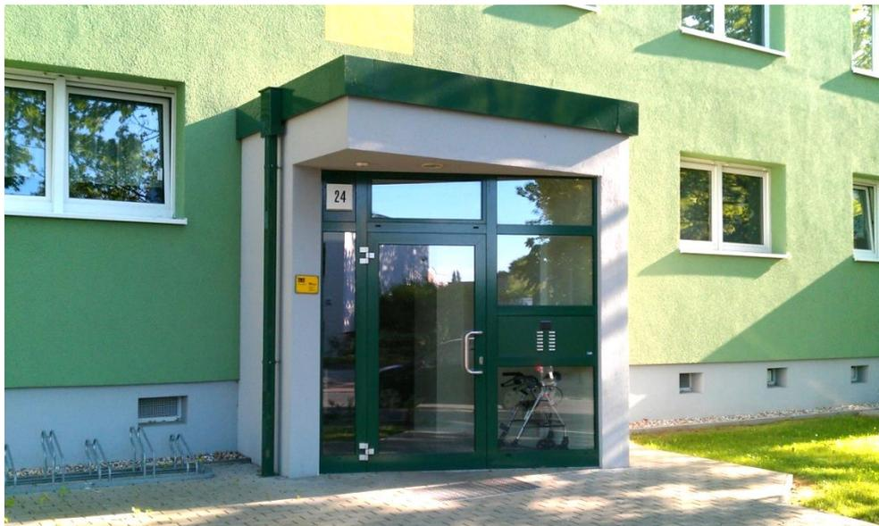
**Abbildung 44: Umbau eines Eingangsbereichs als zusätzliche Abstellmöglichkeit für Rollatoren in Halle (Saale), eigene Aufnahme am 28.5.2012**
