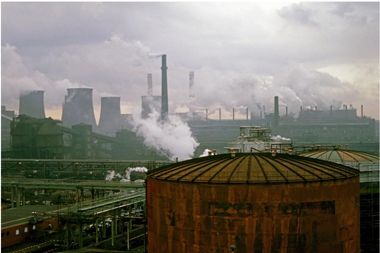
Abb. 1: Kraftwerk Espenhain 1989 (Quelle: https://www.fotocommunity.de/photo/espenhain-ddr-1989-bernd-wilster/42140277 )
