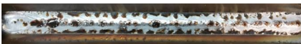
Abb. 1: Eine 3-lagige Kehlnaht, geschweißt mit einem G 4Si1 Ø1,2 mm ohne Analyseinschränkung, Schutzgas M21-ArC-18, zeigt ein hohes Aufkommen an Oxiden/Silikaten auf der Oberfläche, schwer entfernbar
