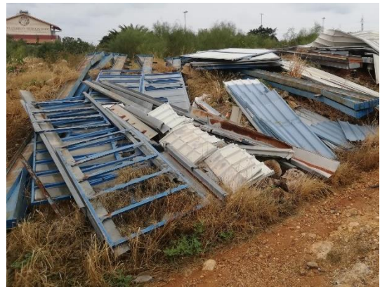
Abb. 4: Wiederverwendung eines Tragwerks mit „Demontage und Zwischenlagerung“
