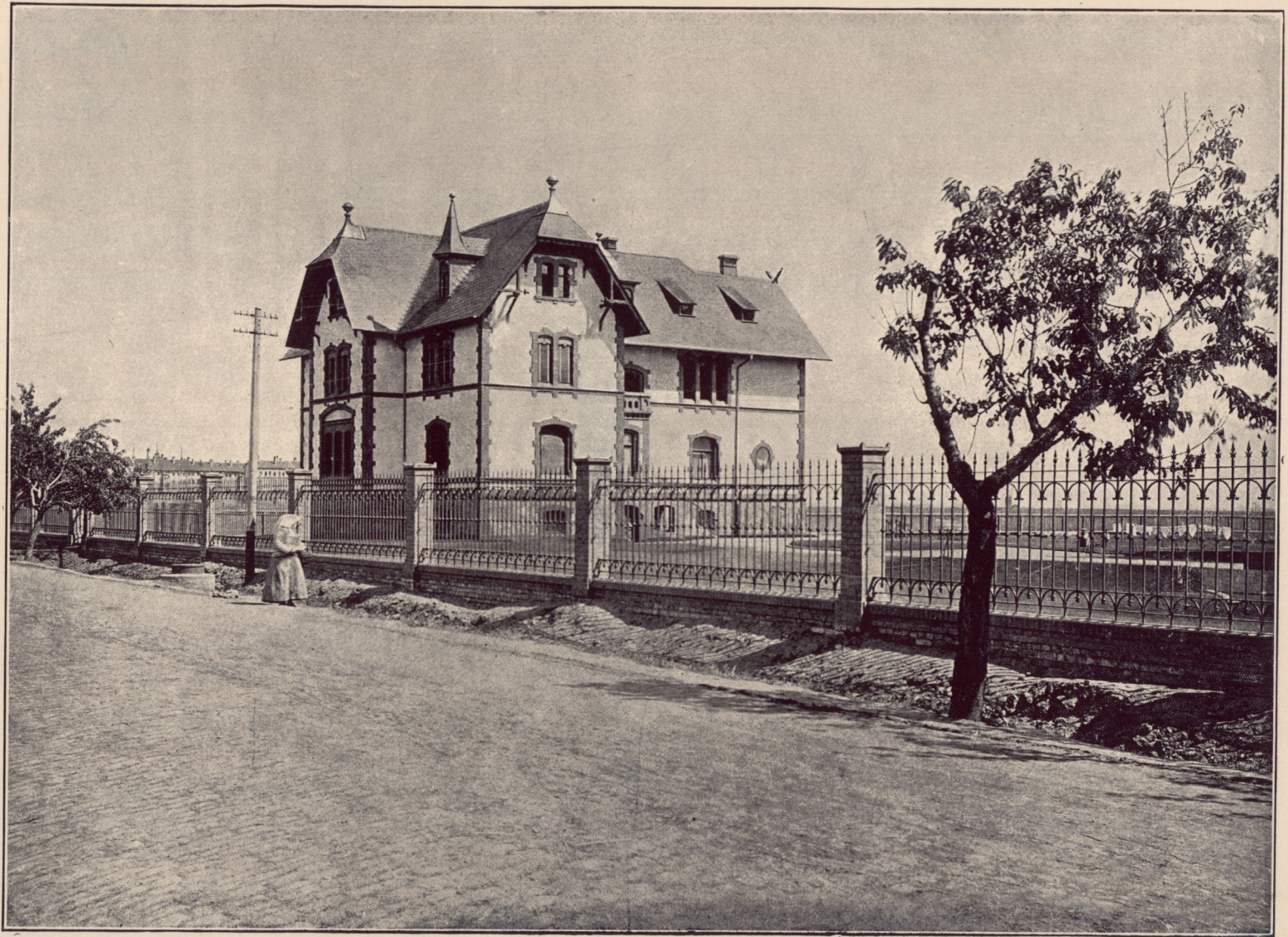
Chefarztwohnhaus von Südwest.
