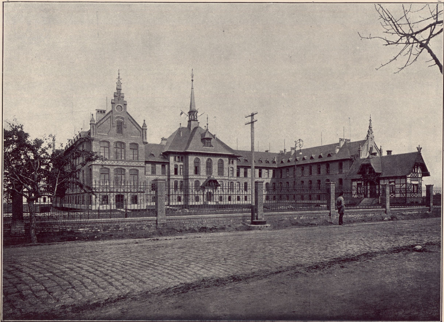
Ansicht von der Strasse.
