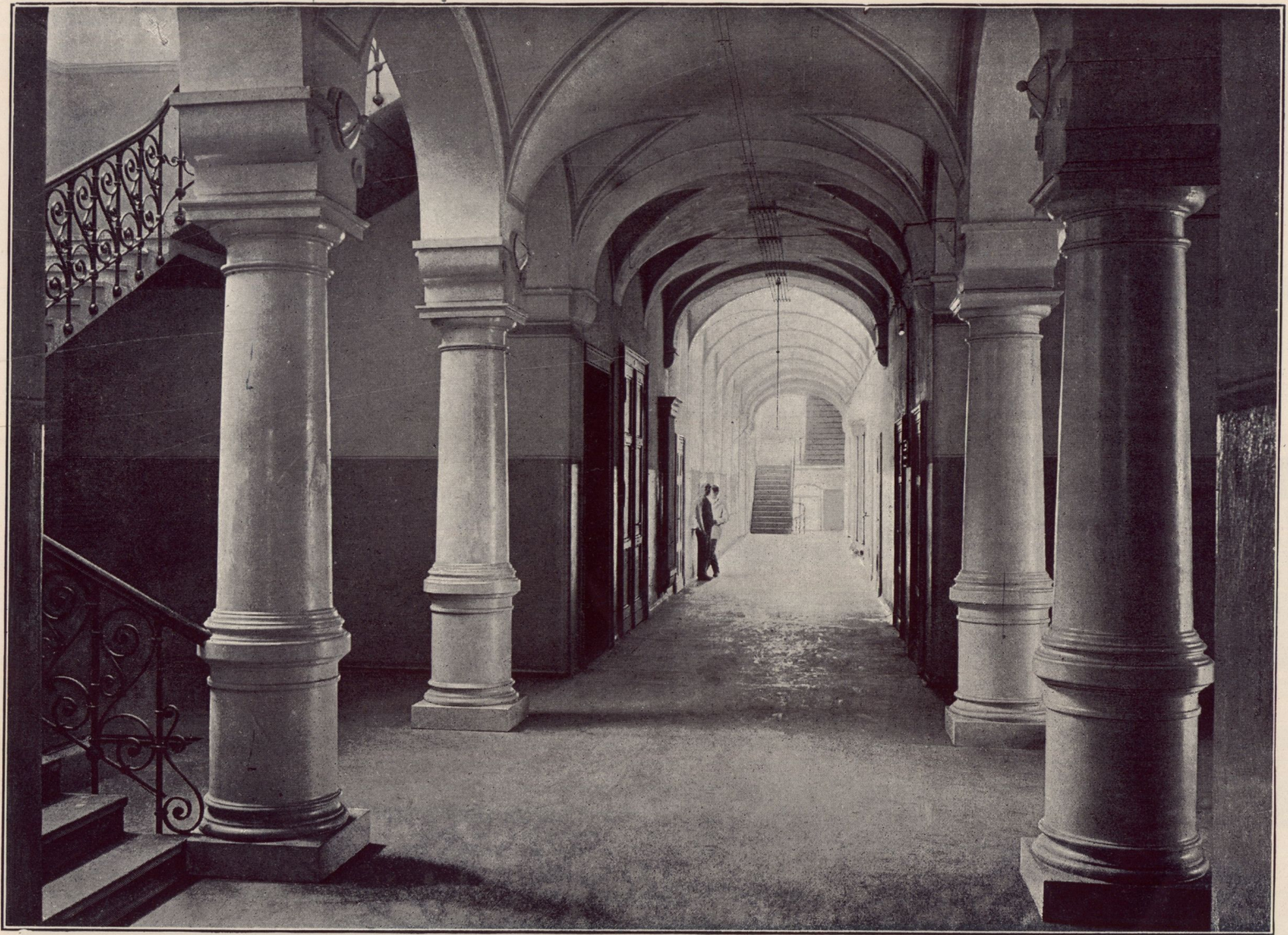
Treppenhaus mit Blick in den Hauptcorridor.
