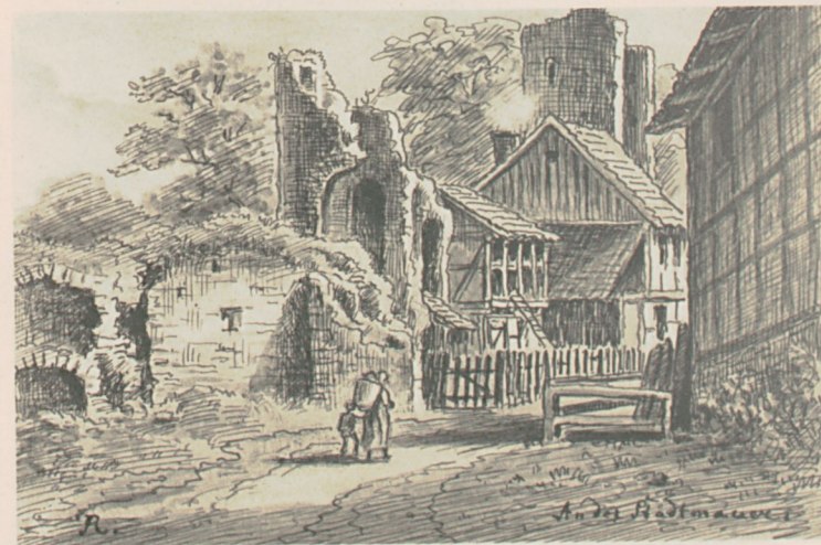
Mauer und Mauertürme auf der Steingrube. Jetzt Große Bergstraße.
