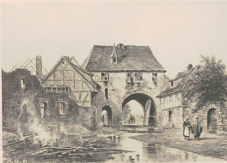
Vorbau des Rinfektors unmittelbar nach dem Brande vom 8. Februar 1855.
