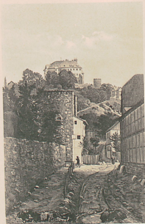
Stadtmauer auf der Steingrube. Jetzt Große Bergstraße.
