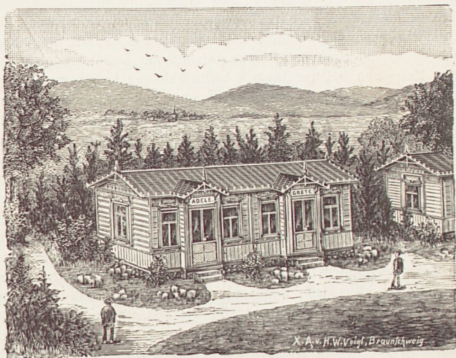
Lichtlufthäuschen des Jungborn.
