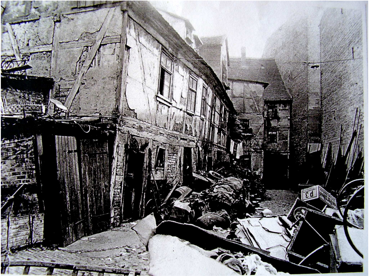
Verfallenes Fachwerkhaus in der Geiststraße.
