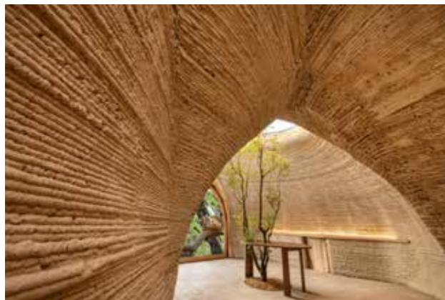
Neue Bautechnologie als Branding. Auch im Zoo wird bereits mit Lehmbauten aus dem 3D-Drucker experimentiert. Collage: William Chen
