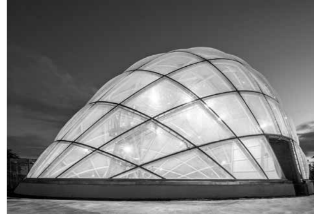
Gewächshaus im Botanischen Garten, Aarhus Kissenoberfläche: 1.800 m 2 Grundfläche: 1.145 m 2 Bogenhöhen bis zu 17,5 m Bogenspannweiten bis zu 41 m ETFE-Folie in 200–150–250 µm Anzahl Kissen: 88 feststehende zweilagige Kissen, zwei öffnere Firstkissen, 34 dreilagige Kissen mit pneumatischer Verschattung
