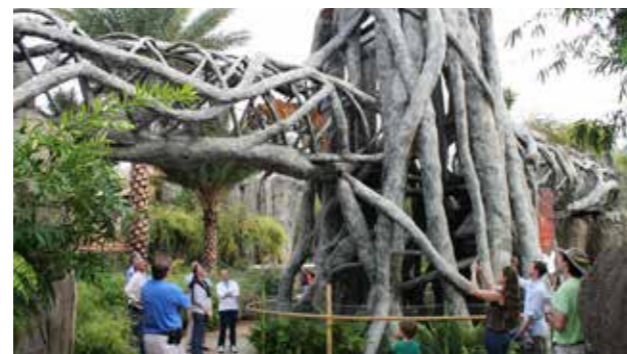
Tunnelkonstruktion aus ummantelten Stahlträgern Foto: Jacksonville Zoo and Gardens
