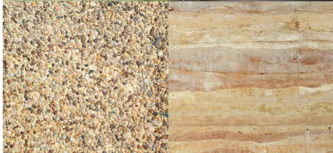
Tragende Wände aus Lehm Die Stampflehmtechnik, bei der lagenweise erdfeuchter Lehm in eine hölzerne Schalung gefüllt und verdichtet wird, war in Mitteleuropa ab dem ausgehenden 18. Jahrhundert verbreitet. Das Haus in traditioneller Bauweise wird mit modernster, digital vernetzter Technik ausgestattet.
