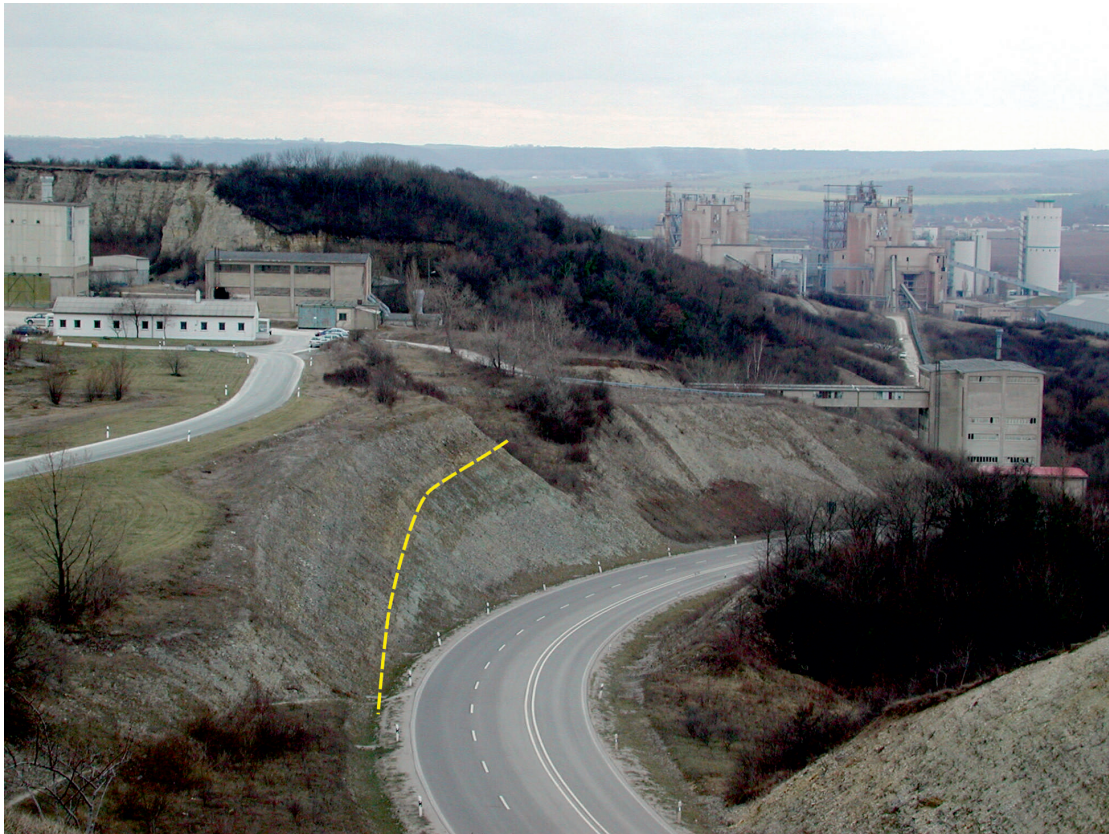
Abb. 17: Teilstück des Straßeneinschnittes Karsdorf im Bereich der Röt-Muschelkalk-Grenze (gestrichelte Linie), im Hintergrund das Zementwerk.
