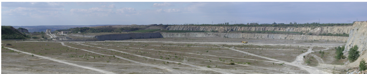
Abb. 20: Blick in den Kalksteintagebau des Zementwerks Karsdorf.
