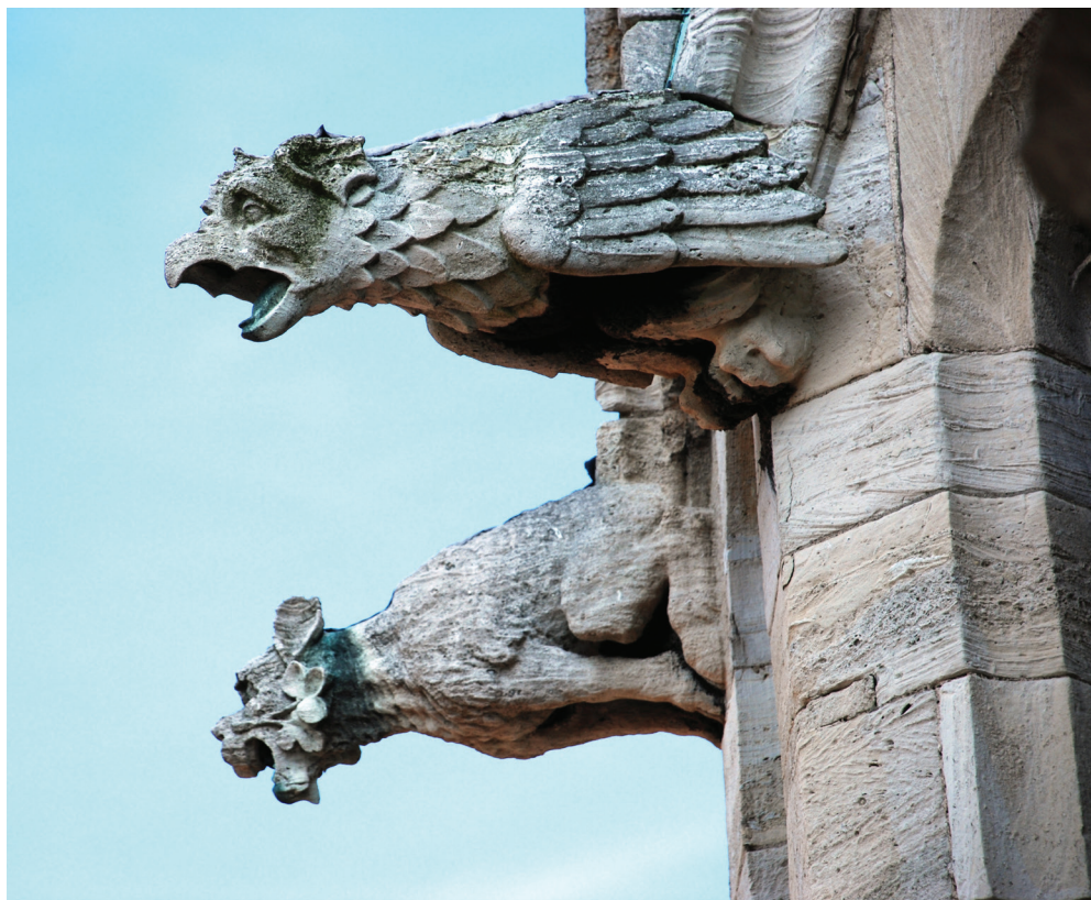
Wasserspeier aus Werksteinen (Schaumkalk) der Jena-Formation am Naumburger Dom. Foto: Dipl. Ing. R. GILLNER, Leipzig.
