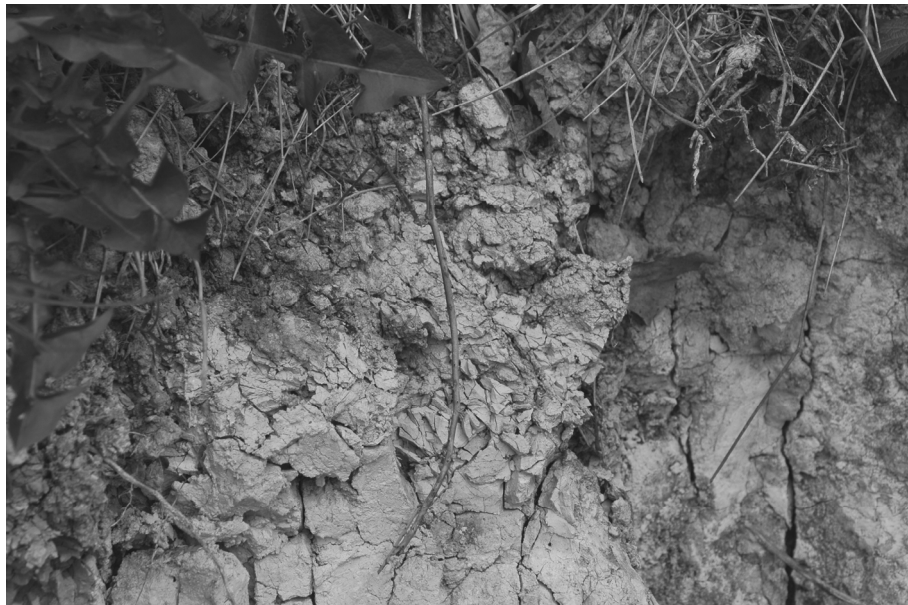
Abbildung 7 Aggregat- bzw. Trennflächenbildung in weichem tertiärem Ton durch wiederholte Austrocknung und Wiederbefeuchtung.
