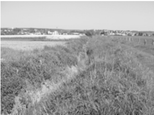
Abb. 1: Wenkbach Unterlauf, mit strukturarmen, verkrauteten Trapezprofil. Foto: H. Trier (2009).
